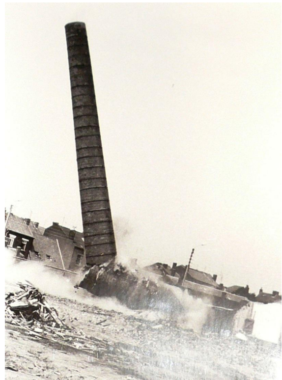
Dynamitage de la cheminée de l'usine Derville et Delvoye, dans le quartier cominois du Vieil-Dieu, en 1990 (MRc1900).
